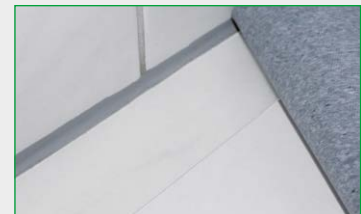
Randverstärkung auf keramischen Fliesen.
