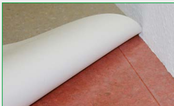
Randverstärkung bei vollflächiger Trockenverlegung.
