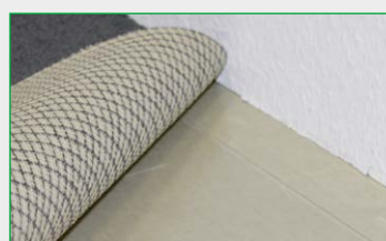
Randverstärkung bei vollflächiger Trockenverlegung.
