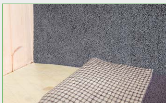
Einlegen des Textilbelags in die vorgeklebte Fläche.
