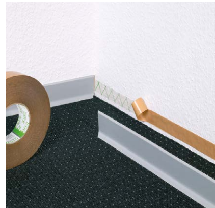
Verklebung einer Hartkernsockelleiste
