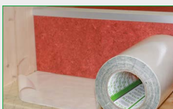
Verklebung eines Linoleum-Belags.
