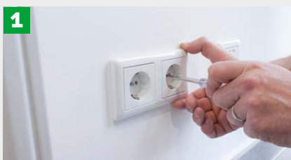
Schritt 1: Steckdosenblenden abschrauben.
