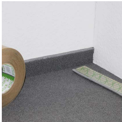
Verklebung einer Kettelsockelleiste
