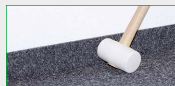
Anschlagen eines frisch verklebten Nadelvlies-Belags
